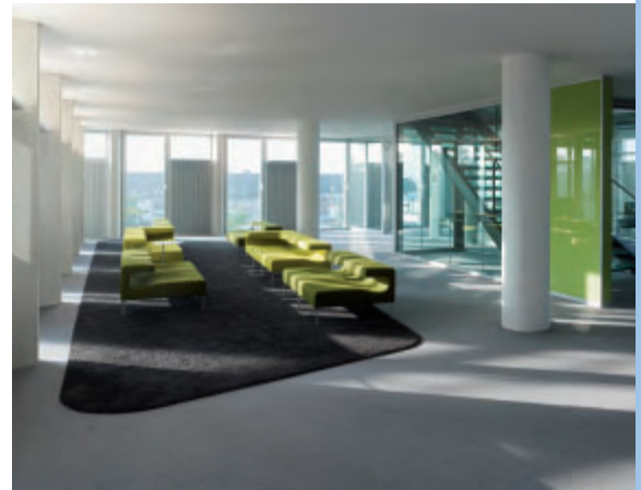
CAPRICORN House, Düsseldorf (D) Air-water system with façade ventilation units
