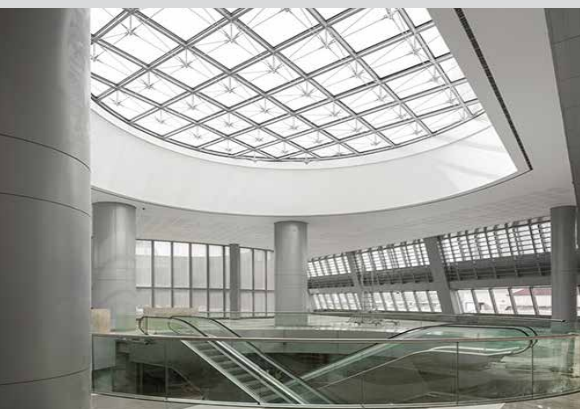
ALS installed in the Krystal Kule, Istanbul (Turkey)
